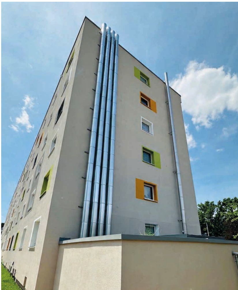
Wärmepumpenanlage St. Johannis.
